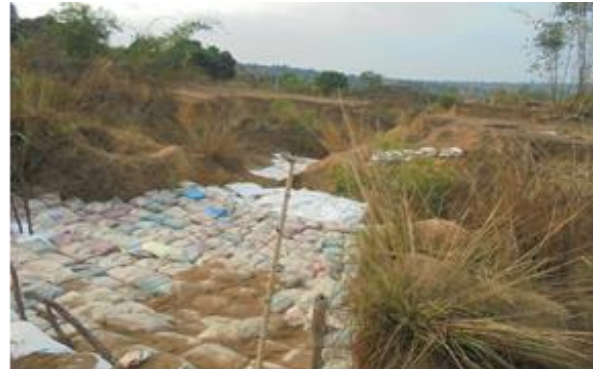
Figures 10 et 11: Sacs remplis de sable pour maintenir le glissement de terrain à Mont-Ngafula
